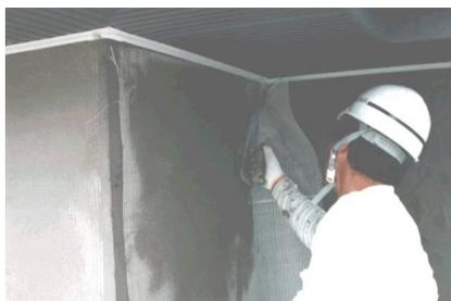
メッシュ埋込みした後の表面のノロ掛けを金コテなどで、平滑・滑らかに仕上げてしまうと仕上げ塗りの漆喰の石灰ミルクのモルタルへの染み込みや食い付きが悪くなりますので、滑らかにし過ぎずに仕上げ材の食い付きの確保を行ってください。
